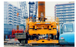
鋼管杭施工 全回転チューピング装置 (RT)
